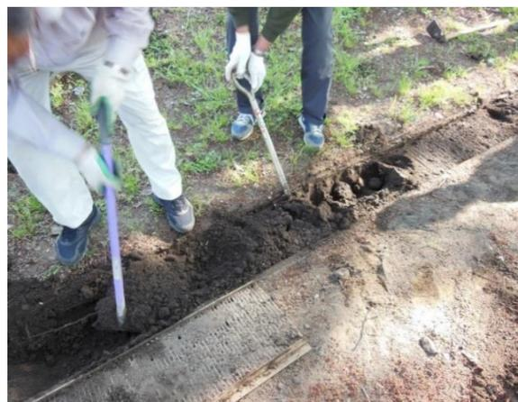
グレーチングを外ずし堆積した砂の撤去作業中です
